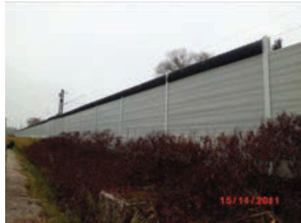
Bild 46: Ansicht Schallschutzwand mit Aufsatz Feldseite
