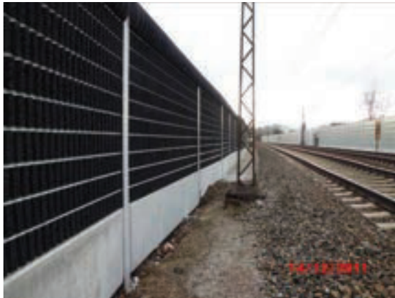
Bild 45: Ansicht Schallschutzwand mit Aufsatz Gleisseite
