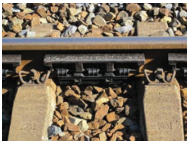
Bild 4: Beispielfoto für die Technologie Schienenstegdämpfer
