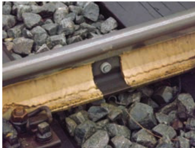
Bild 38: Beschichtetes Schienenstück
