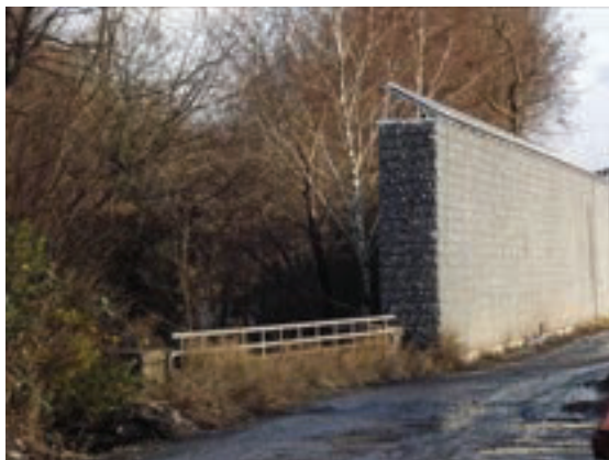
Bild 41: Gabionen-SSW mit FV in Duisburg
