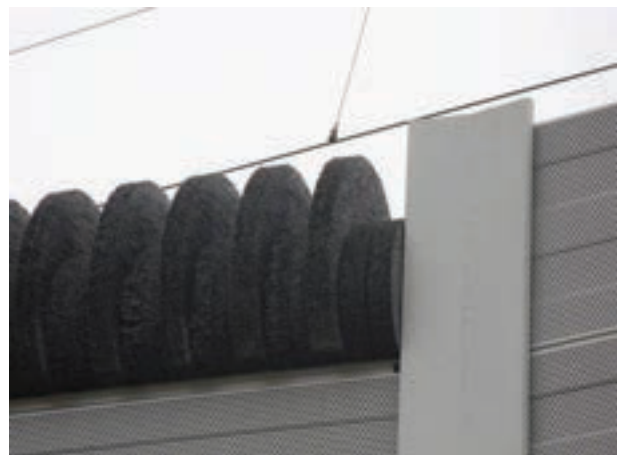
Bild 44: Beugekante als Aufsatzelement auf SSW
